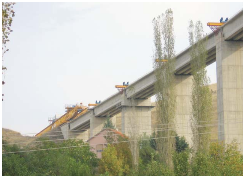
Picture 10 - Viaduct in construction on the section n.12 Beljakovci-Kriva Palanka
